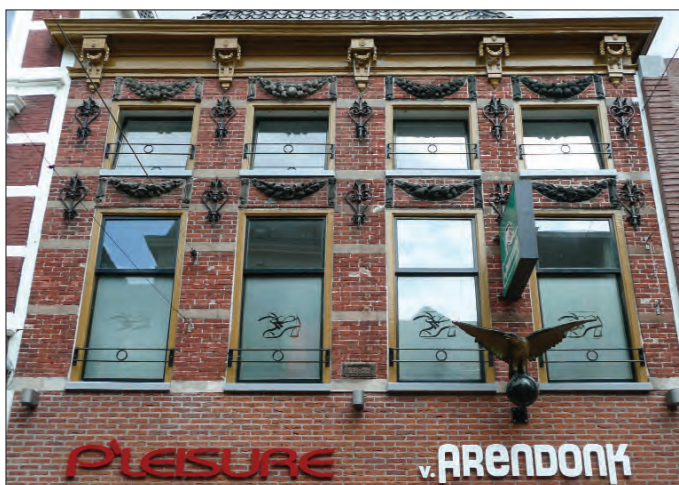
Afb. 18. Herestraat 28, 30, voorgevel. Foto: Taco Tel, collectie Dienst RO/EZ.
