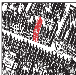
Afb. 20. Herestraat 28, 30, detail van de kaart van Haubois uit omstreeks 1643. Kaart: collectie RHC Groninger Archieven.
