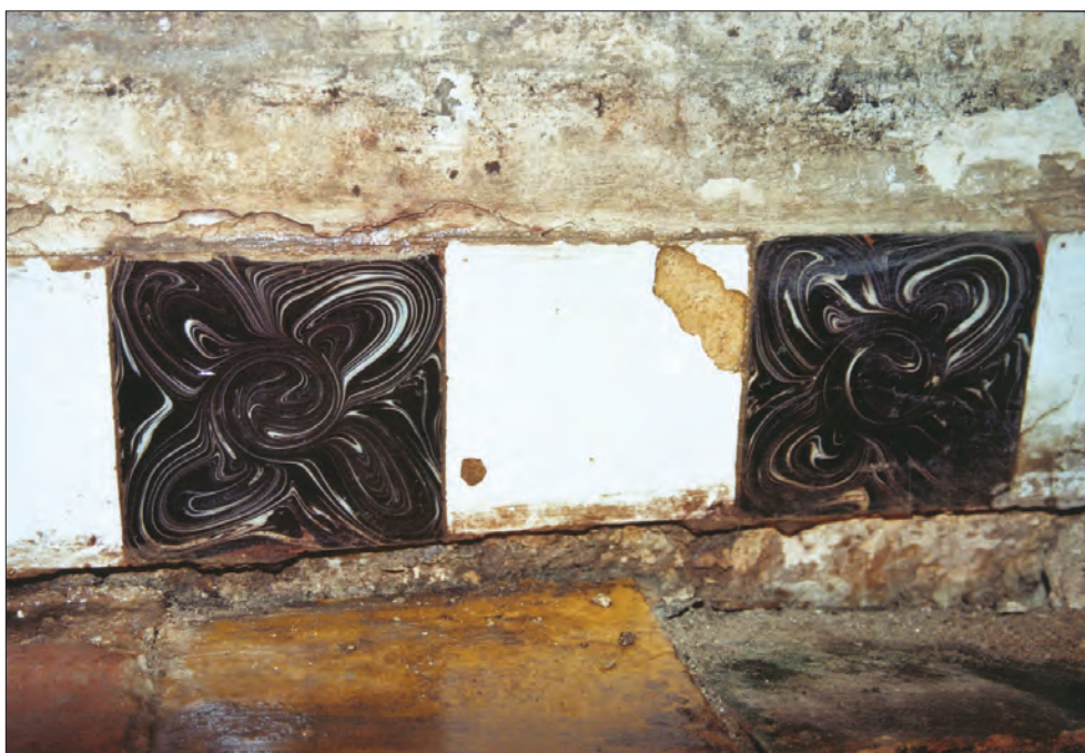
Afb. 29. Vismarkt 44, foto van de plint tegen de rechtermuur in de voorkamer op de begane grond.
