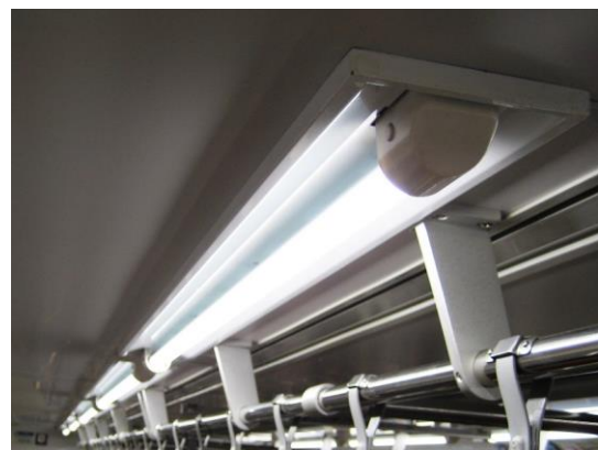
【車内に搭載したLED照明】
