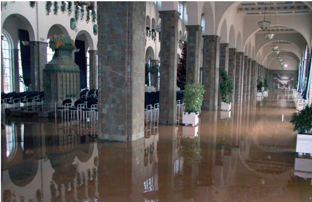
Überschwemmung am 02./03.01.2003 in Bad Kissingen an der Fränkischen Saale (Quelle: THW Forchheim)
