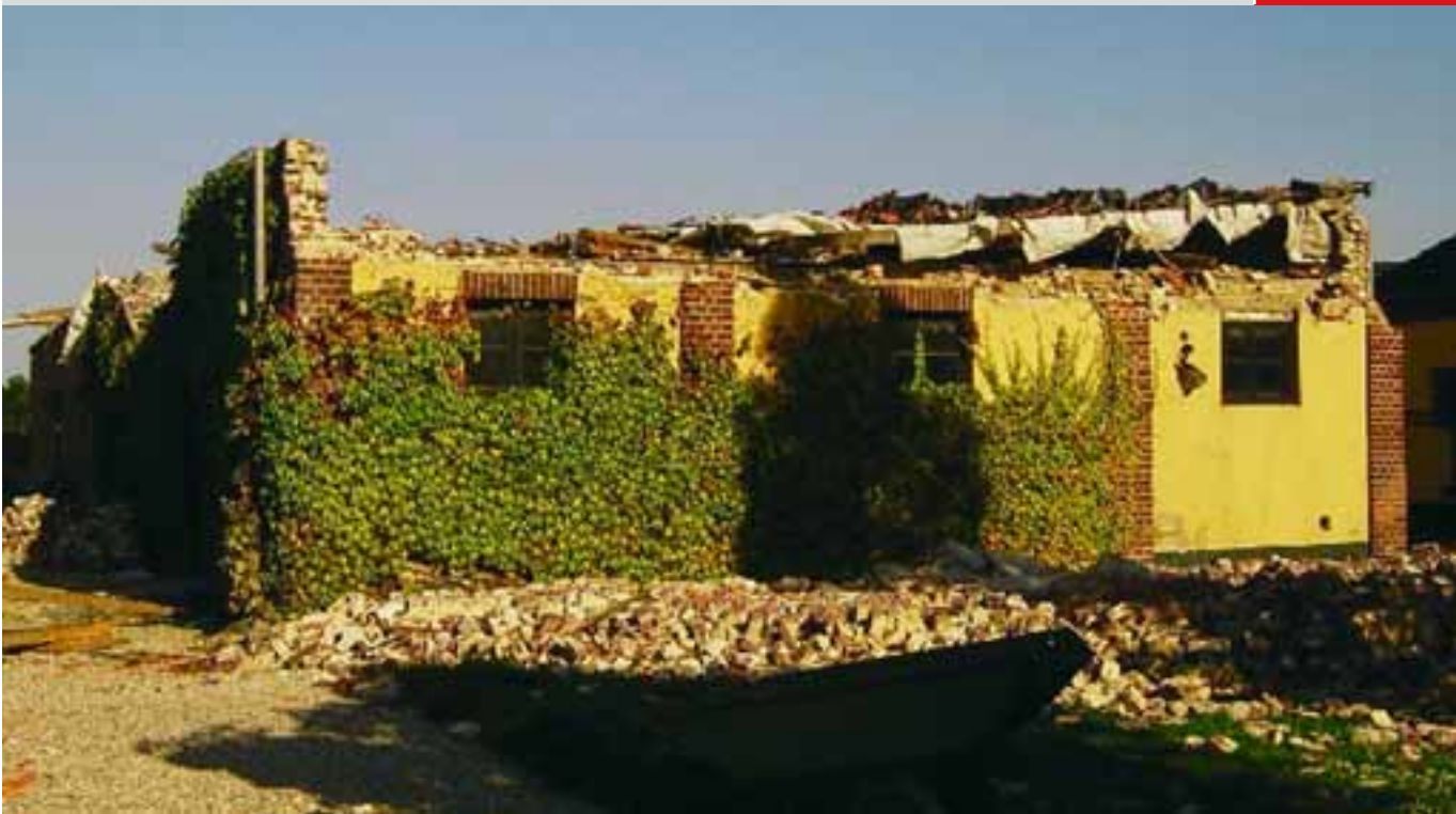
Abbildung 19: Durch einen Tornado am 18.07.2004 total zerstörtes Gebäude in der Nähe von Tönisvorst / Nordrhein-Westfalen (Quelle: T. Sävert; www.naturgewalten.de )
