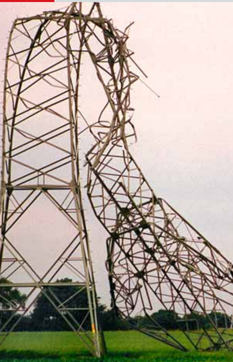
Umgeknickter Strommast in der Nähe von Peine in Niedersachsen nach einem Gewitter am 29.06. 1997 (Quelle: dpa)
