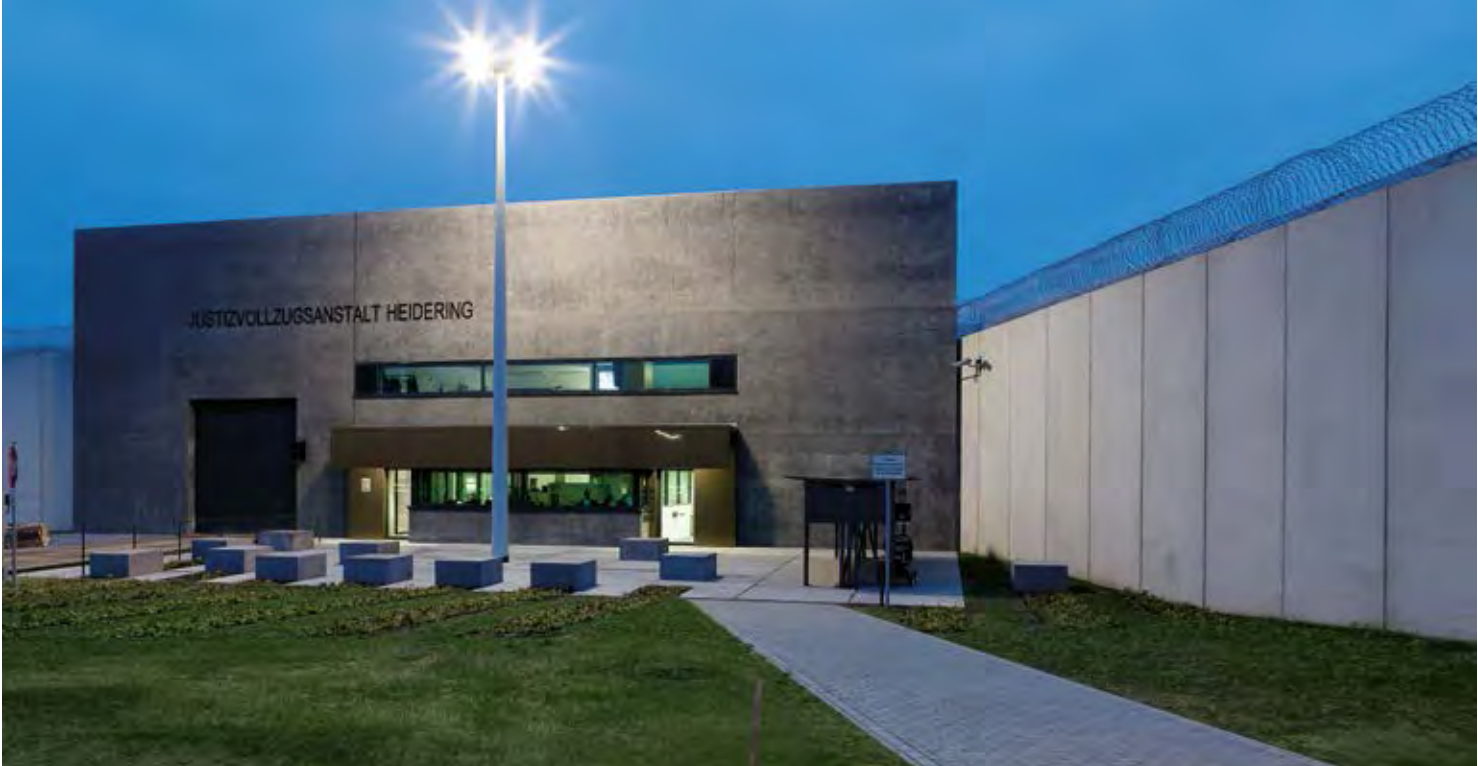
JVA Heidering, Berlin, Deutschland · Germany, alle Fotos · all photos: © seyerlein und seyerlein
