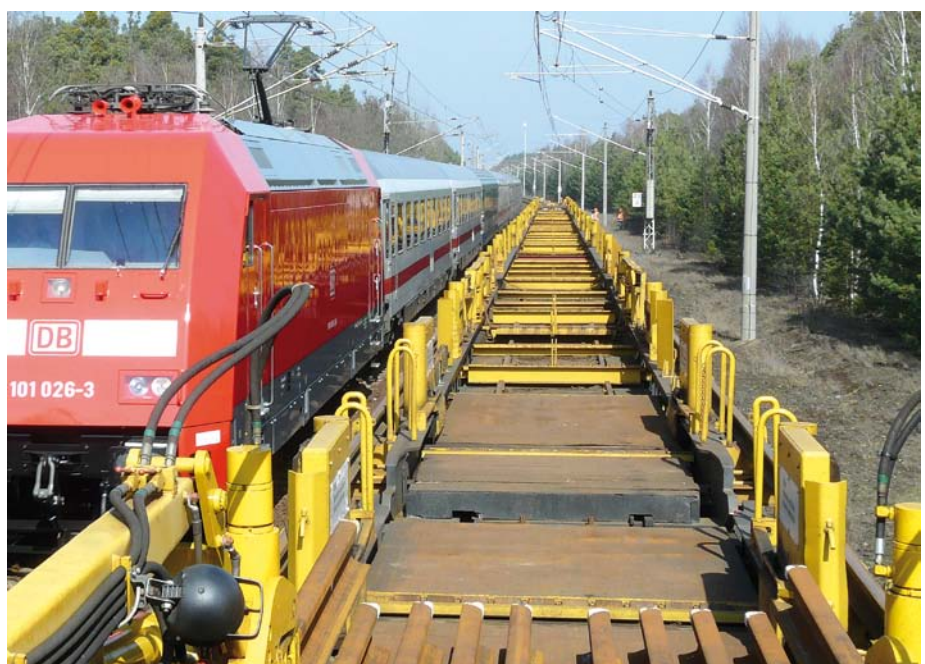
Abbildung 4: Schutzabstand zur Oberleitung des Nachbargleises wird eingehalten
