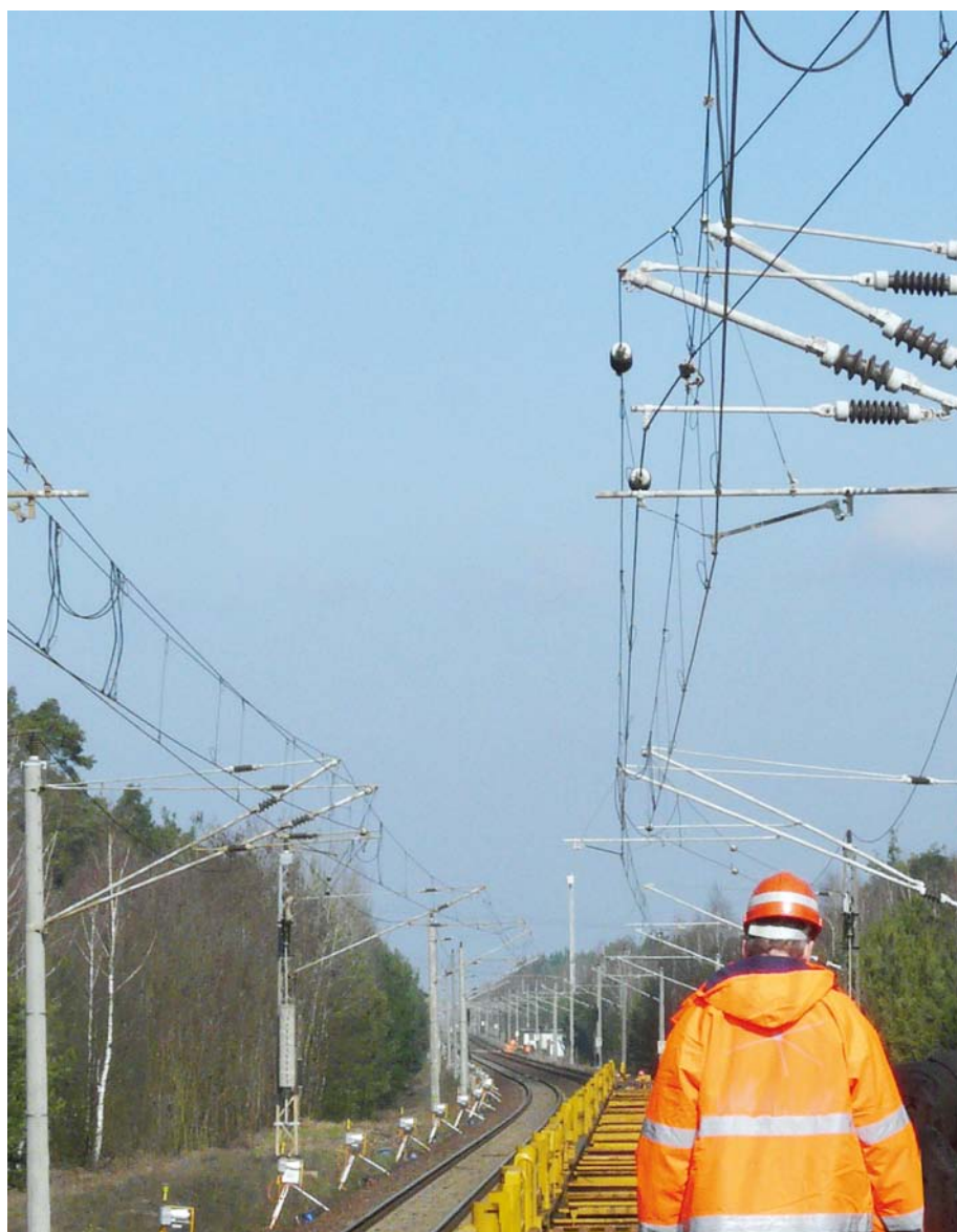
Abbildung 7: Ladung auf Schienenfahrzeugen – Schutzabstand zur Oberleitung im Arbeitsgleis wäre nicht ausreichend
