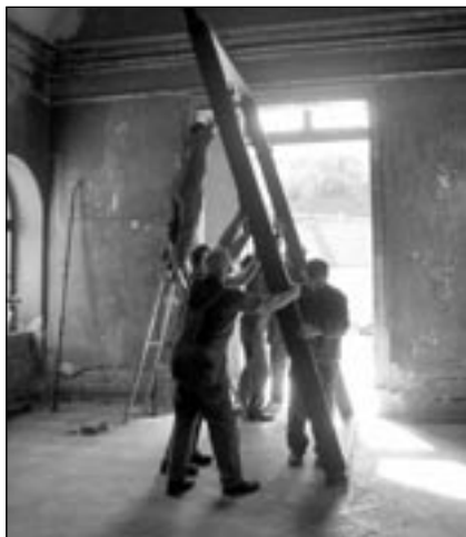
Montáž opravených dveří
