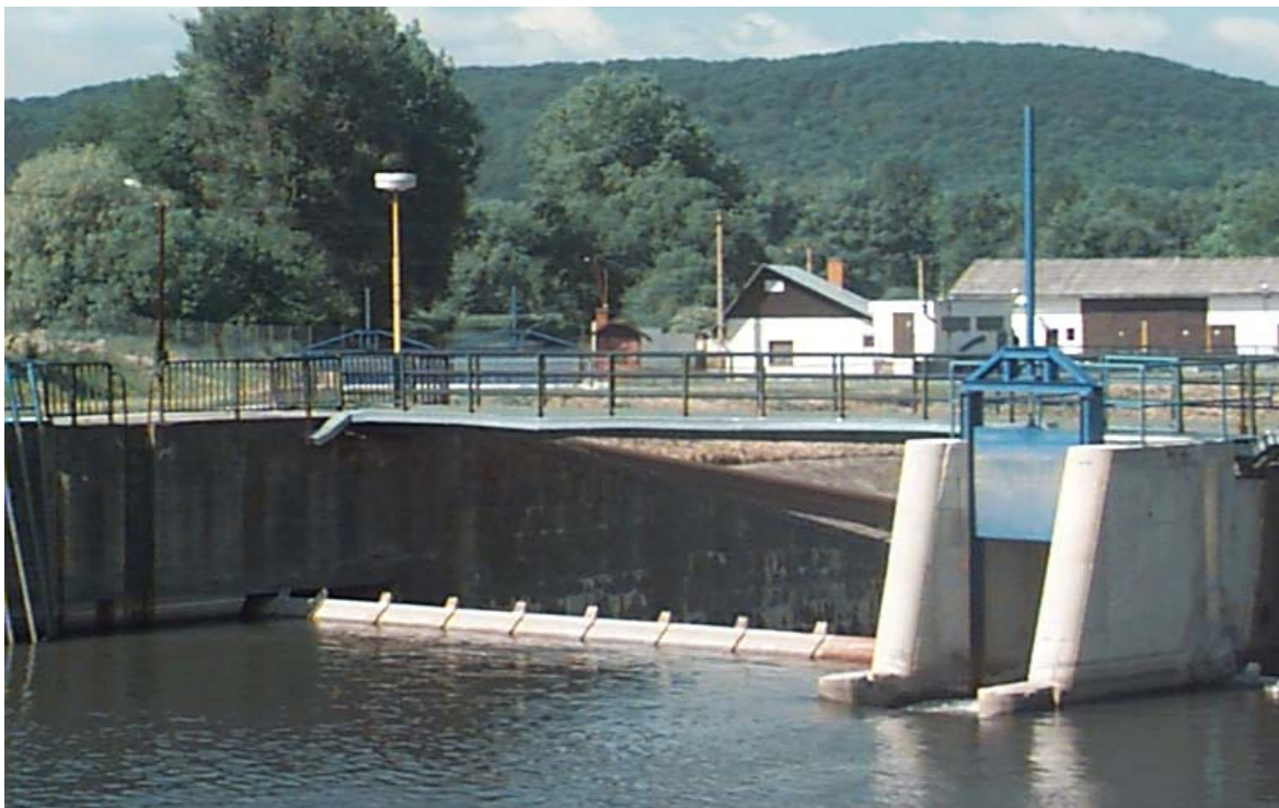
Klapková hať na Hrone (pohľad na 1 haťové pole a stavidlový uzáver)
