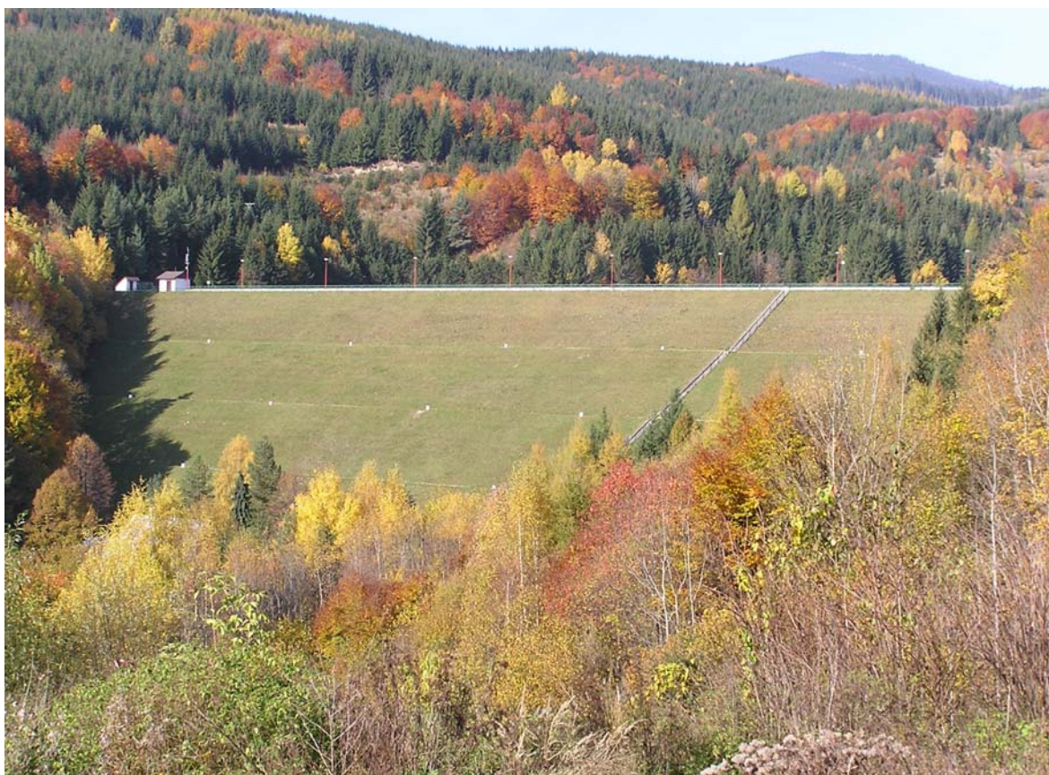
Vzdušný svah hrádzového telesa VN Hriňová
