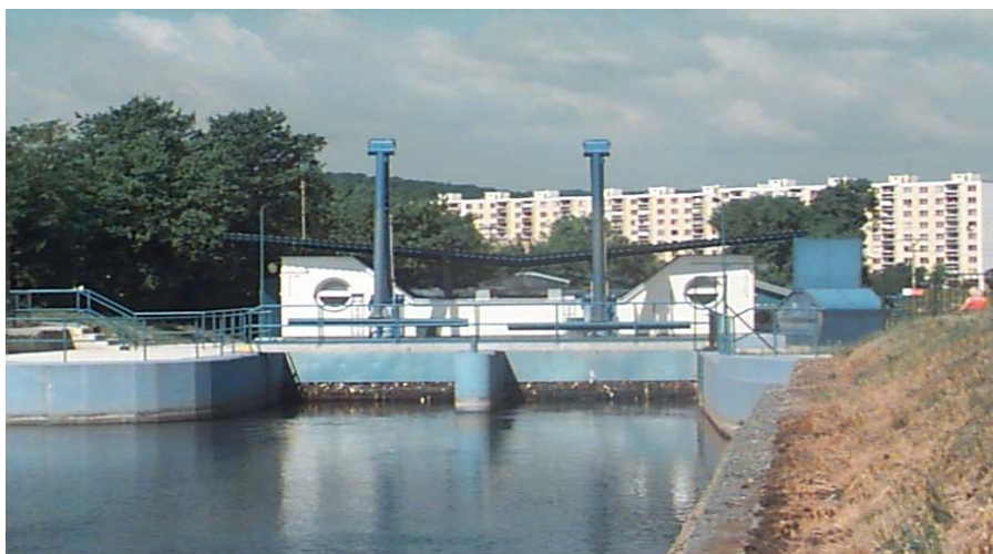
Pohľad na vtok do MVE
