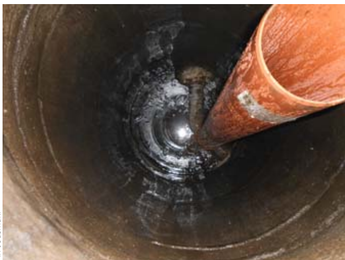
Lahden Tunnelikadun viemärin vanhat betonikaivot jäivät hulevesikaivoiksi. Niiden sisälle rakennettiin jäteveden tarkistusputkia.
