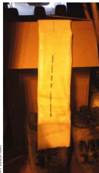
raussukan kovetus käynnissä. Kevyenliikenteenvälät olivat käytössä koko työmaan ajan.
