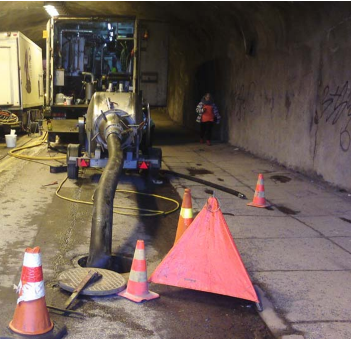
raussukan kovetus käynnissä. Kevyenliikenteenvälät olivat käytössä koko työmaan ajan.
