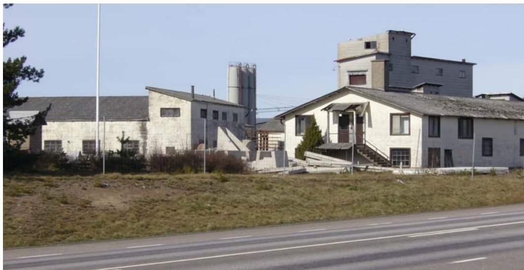
Cementfabriken väster om E20
