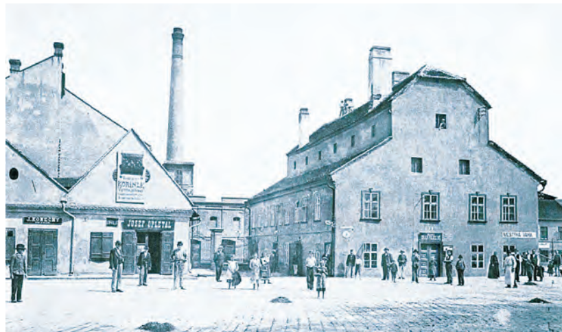
IDYLLICKÝ KLID PŘED RADNICÍ NA PODĚBRADOVĚ NÁMĚSTÍ - VLEVO OD NÍ VCHOD DO MĚSTSKÉ ELEKTRÁRNY, VPRAVO STARÁ VALCHA (KONEC 19. STOL.)
