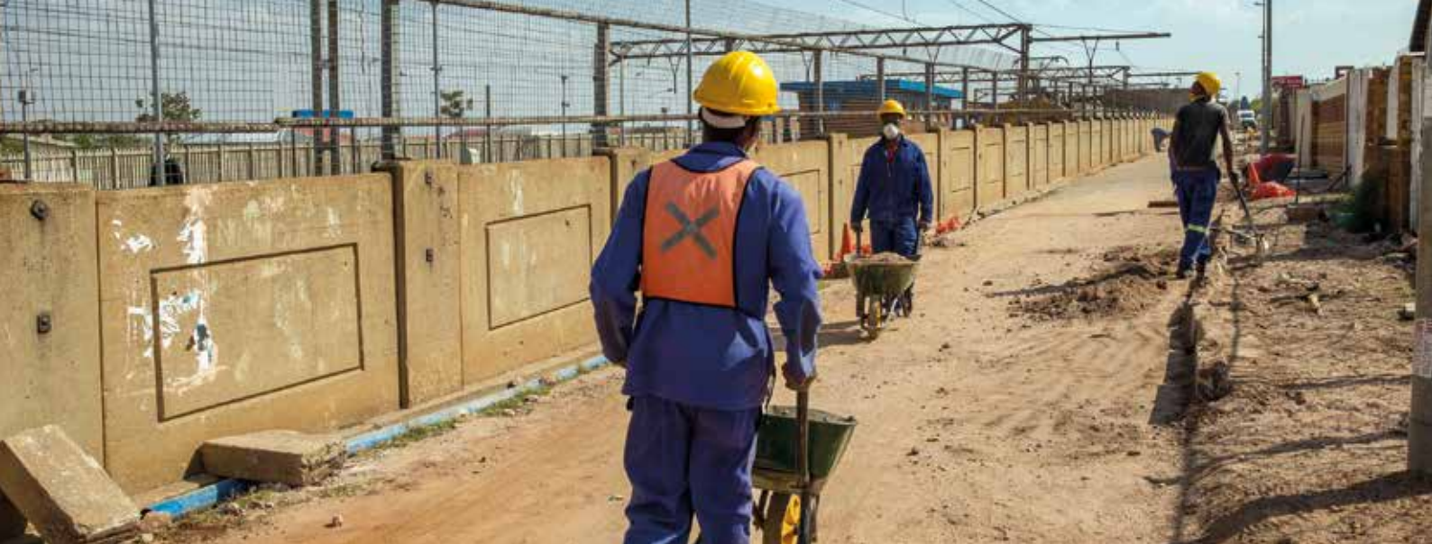
● Afrique du Sud – Réhabilitation du réseau des canalisations et installation de compteurs de prépaiement pour la consommation d'eau à Johannesburg.
