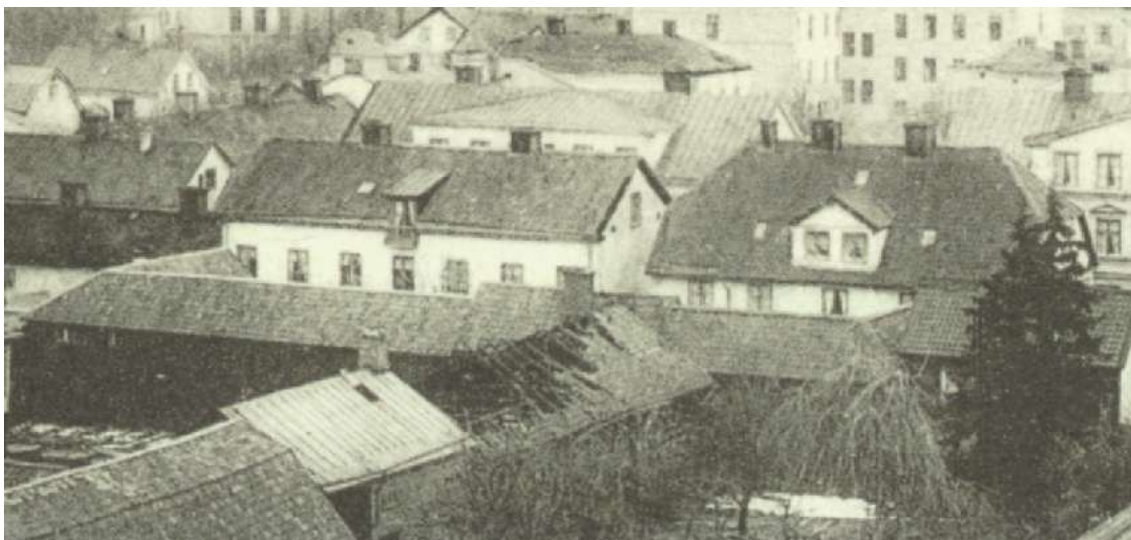
Fig. 8. En del oklarheter råder ännu beträffande tillkomsten av bebyggelsen på tomten, både om längan inne på gården och om husen utmed Nygatan. Bland annat gäller det frontespisen på huset med valmat tak men också rörande åldern på det andra huset. Ändå är det nog knappast alltför djärvt att anta att gården som syns på bilden är just den går där orgelbyggarna Wistenius och Schiörlin bedrev orgelbyggeri. Huruvida Wistenius lade grunden till Linköpingstraditionens orgelbyggeri där redan från början, det vill säga runt början av 1740-talet är ännu en öppen fråga.
