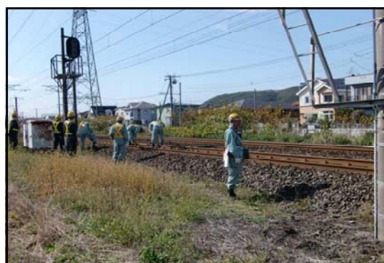
(軌道回路点検作業の診断)
