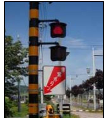
(全方向踏切警報灯【拡大】)
