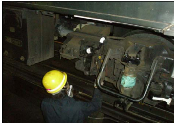
（車両の打音検査）
