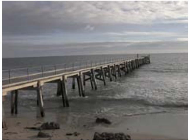
Port Rickaby Jetty
