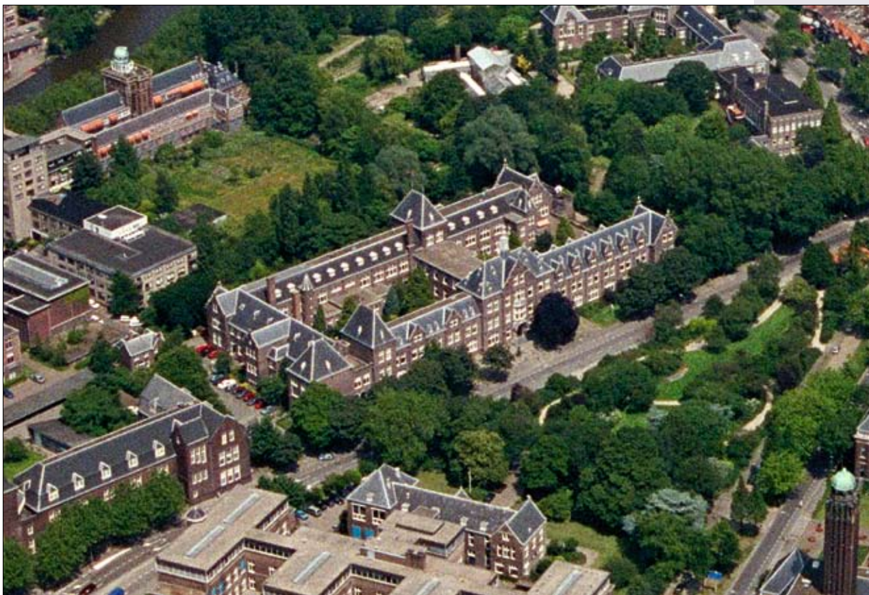
Het Mineralogisch-Geologisch Museum is gehuisvest op de eerste verdieping van de zuidoostelijke vleugel (op foto rechtsvoor) van het binnenkort te sluiten gebouw van Technische Aardwetenschappen, Mijnbouwstraat 120, Delft. Het pand krijgt een nieuwe bestemming.
