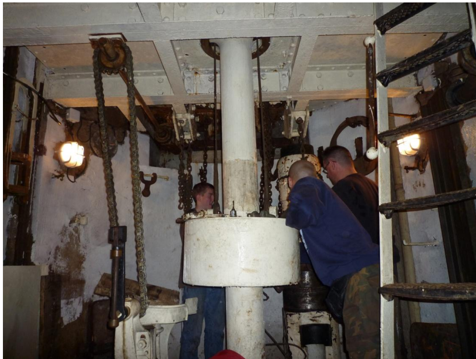
Travaux de restauration tourelle de 15cm
