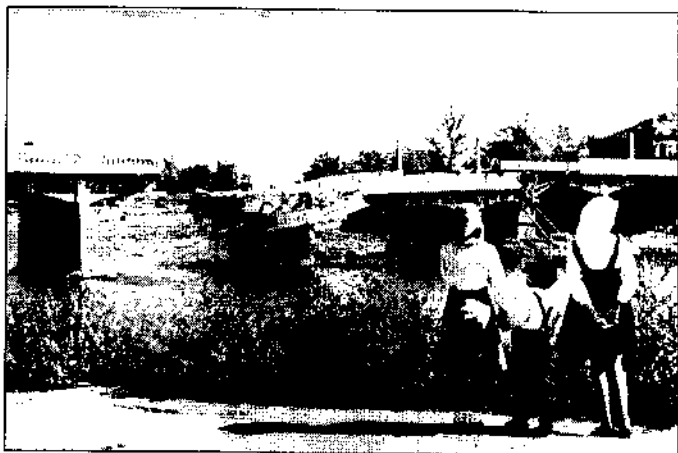
Зруйнований міст через річку Псел. Суми
