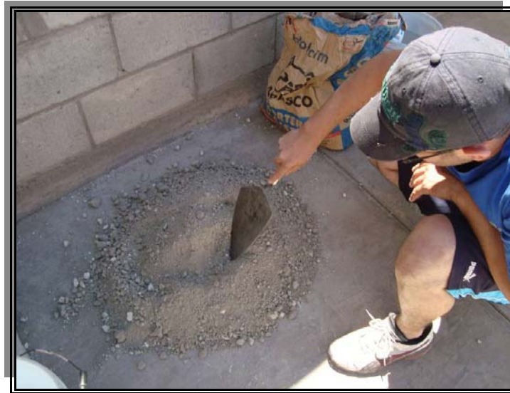
Figura 20. Homogenización del jal y cemento.
