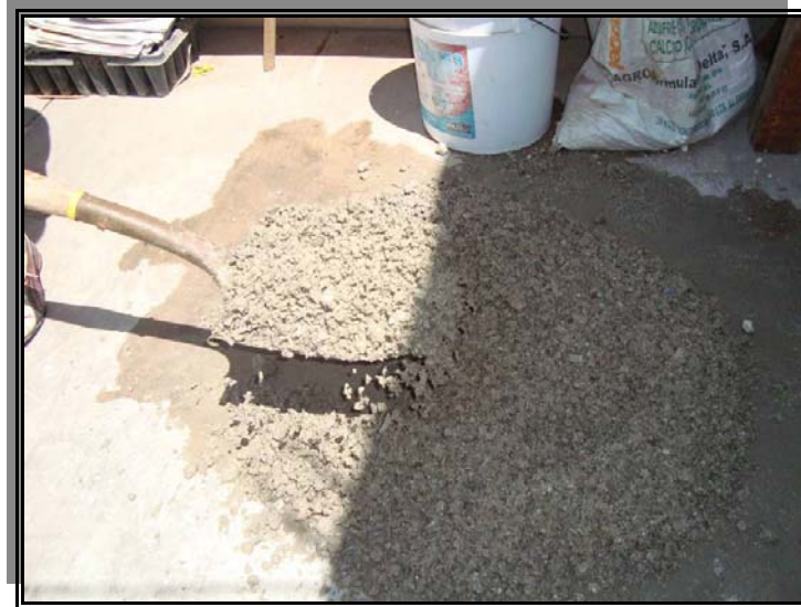
Figura 23. Terminando homogenización.
