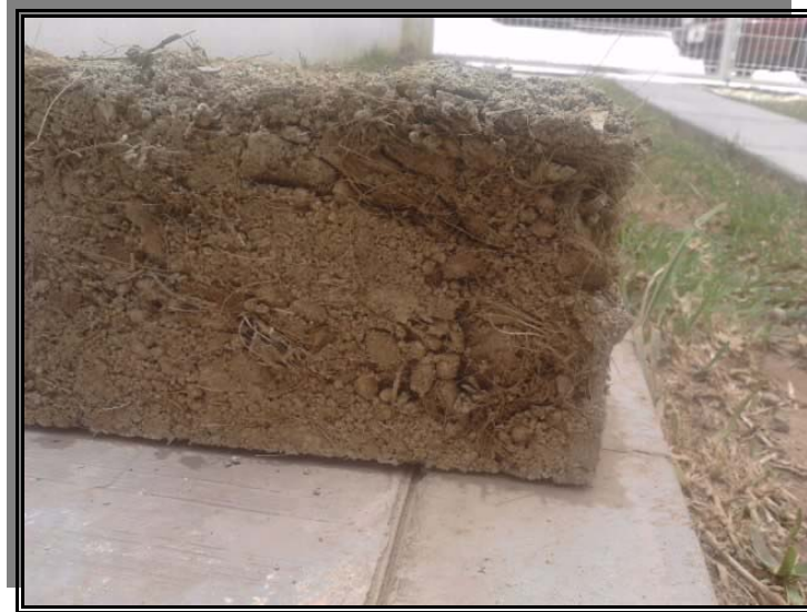
Figura 28. Tabique de prueba con fallas.
