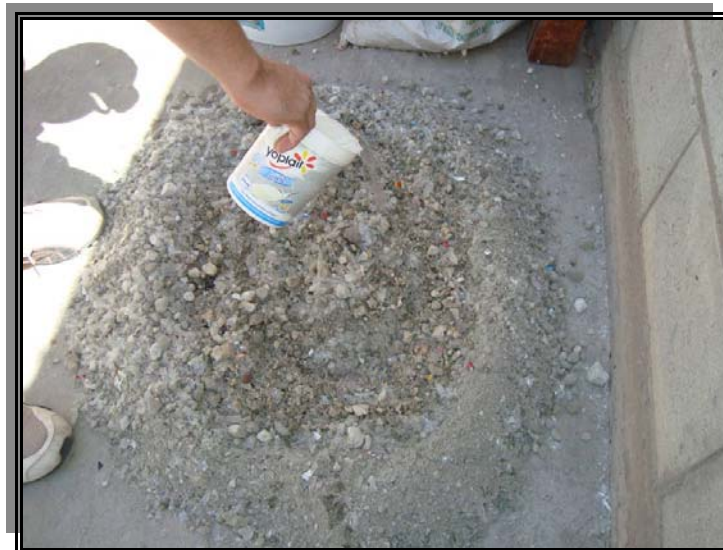
Figura 22. Integración de materiales con agua.
