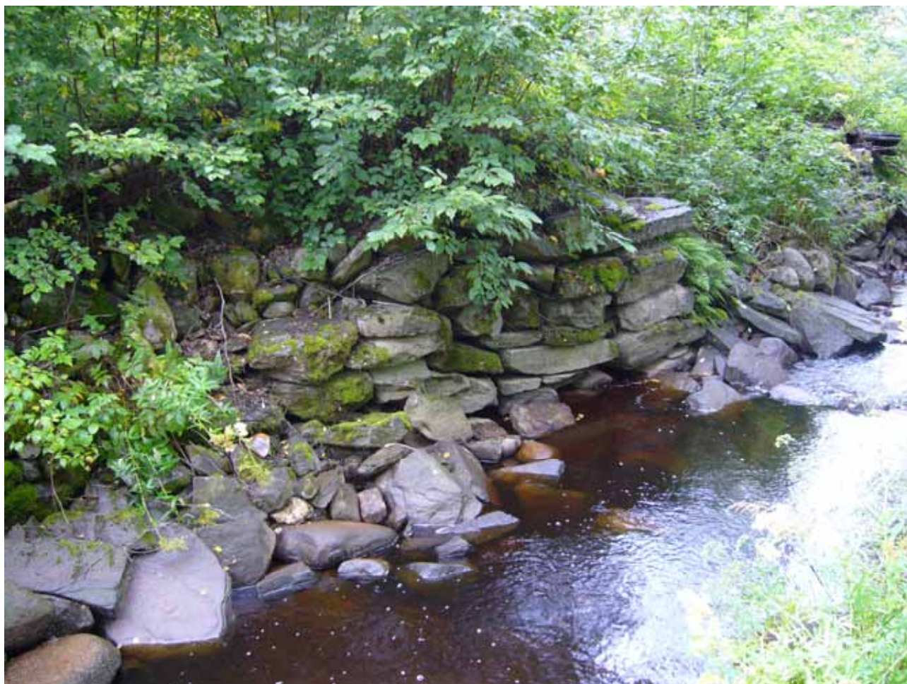
Kohde 58. Rengonkylän silta
