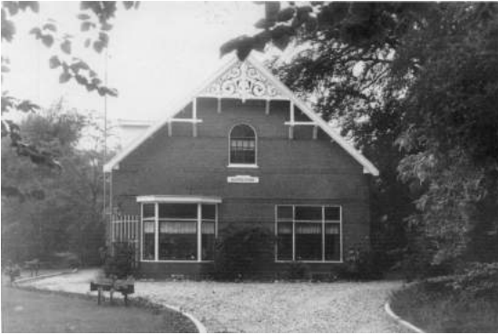
Afb. 33. Het huis Lijsteroord na de verbouwing van 1930.
