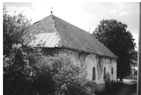
So sah die Kirche 1996 aus. Inzwischen ist das Dach neu gedeckt
