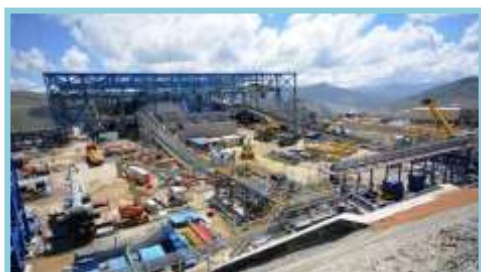
Avance Trabajos de construcción en Las Bambas están al 90%.
