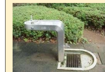
▲車いすでも利用しやすい水のみ器 (つくば市HPより)
