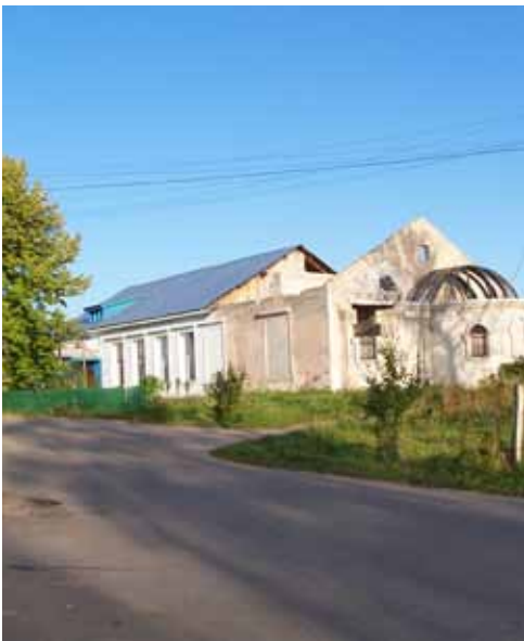
137. Chkalovsk (Nizhnij Novgorod, Russia). Chiesa di Santa Anastasia in fase di ricostruzione.
