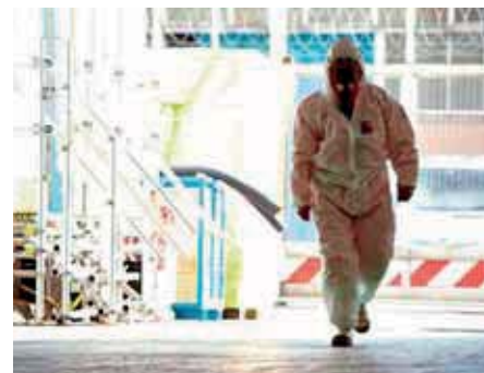
Chapelcross asbestos strip
