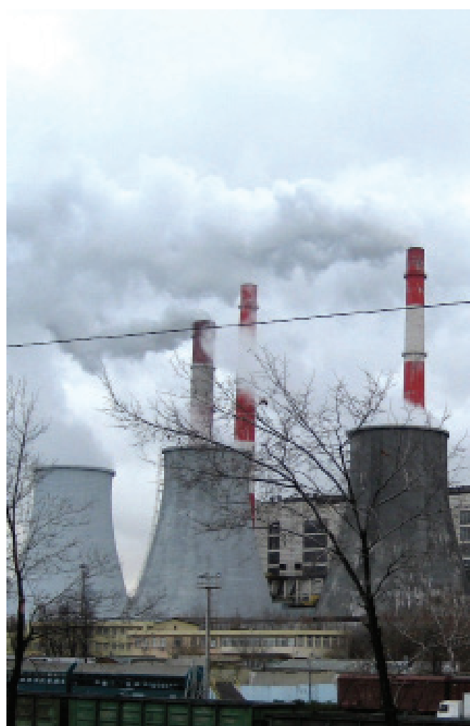
ТЭЦ-20 на улице Вавилова в Москве
