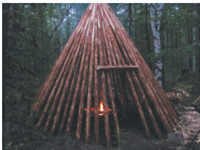
Рис. 23. Воссоздание холомо – возведение наклонных жердей (фотодокумент автора)
