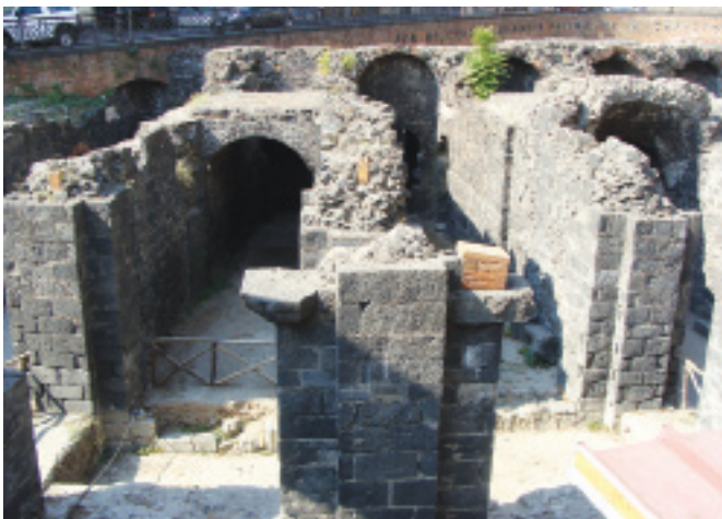
Рис. 24. Амфитеатр в Катанье (Сицилия). При строительстве амфитеатра применена арочно-ордерная ячейка
