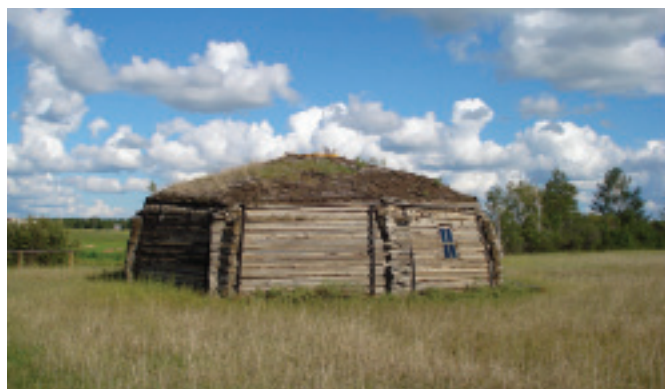
Рис. 13. Подлинник восьмиугольной деревянной урасы (ЧИЭМ)
