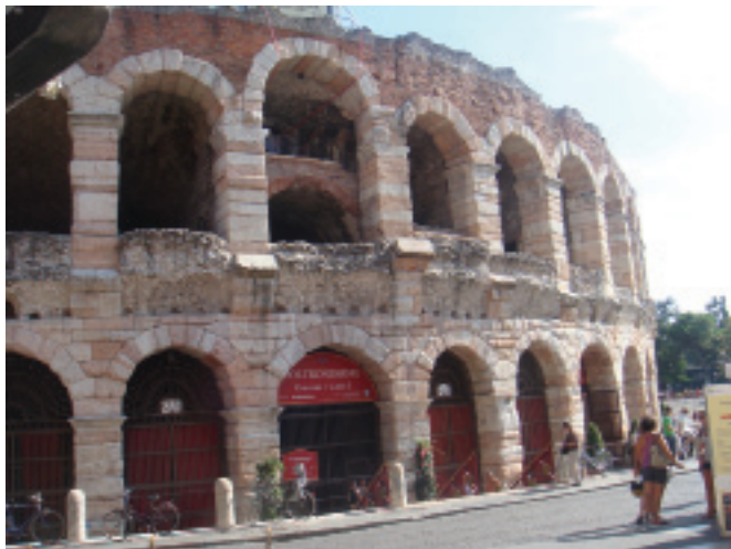
Рис. 30. Амфитеатр в Вероне. Можно видеть пять цилиндрического свода, который шел по всему периметру сооружения
