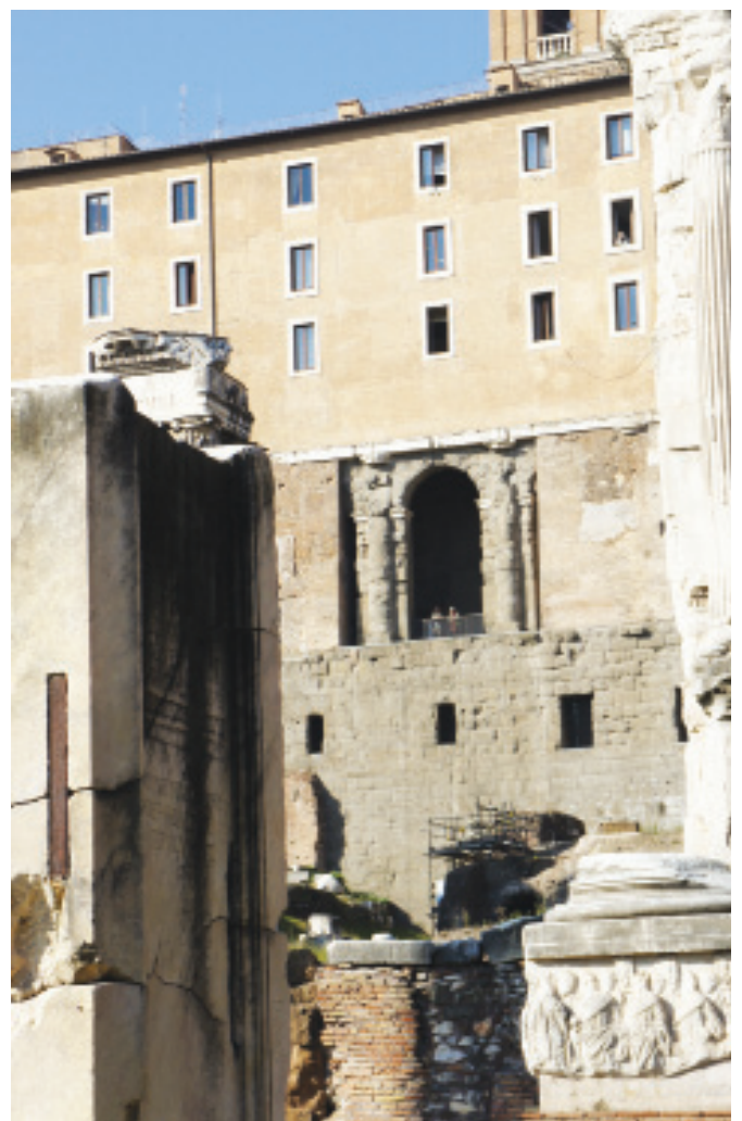
Рис. 11. Табуларий в Риме. На фасаде видна самая ранняя из дошедших до нас римских арочно-ордерных ячеек
