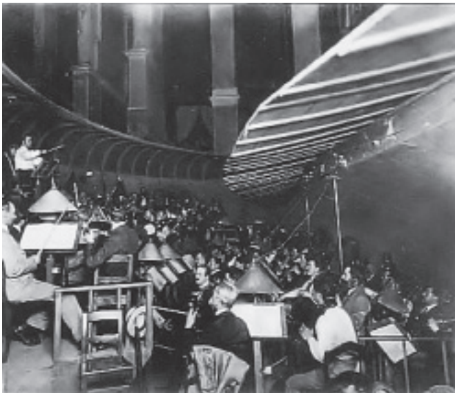
Оркестровая ступенчатая яма. Козырьки нависают как со стороны зала, так и со стороны сцены
