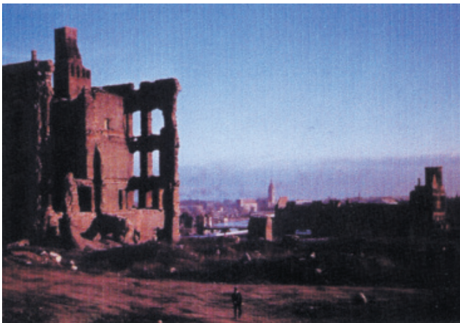
Калининград. Разрушение Королевского замка в 1965 году
