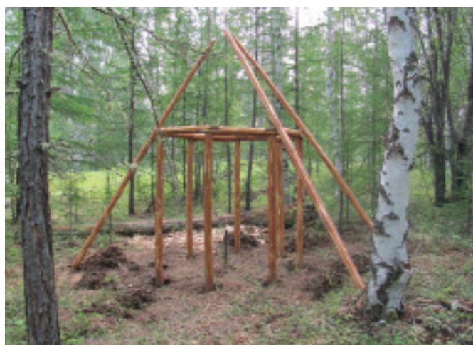
Рис. 22. Воссоздание холомо – возведение внутренних стоек с верхней обвязкой (фотодокумент автора)
