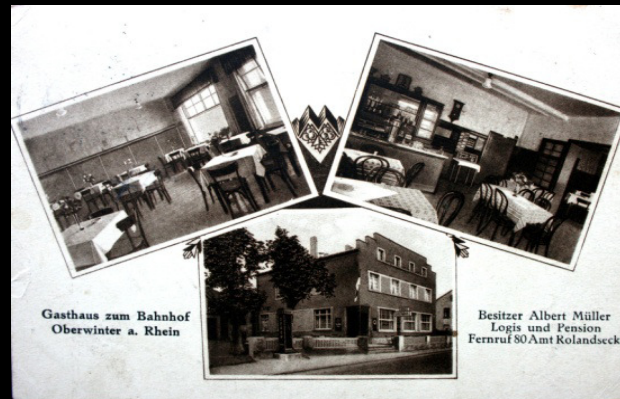
Das Bild des Neubaus wurde 1931 nach Bubenheim versandt
