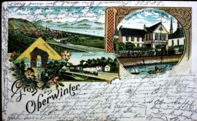
1900 warb man mit dem Rolandsbogen und dem neuen Bahnhof
