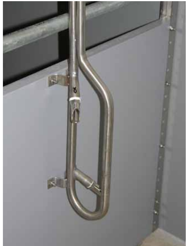
Zapfentränken in unterschiedlicher Höhe mit Schutzrohr gegen Verletzungen
