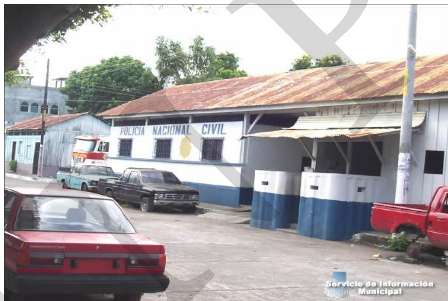
Figura No. 4 Sub-estación de PNC ubicada en el área central del municipio.
