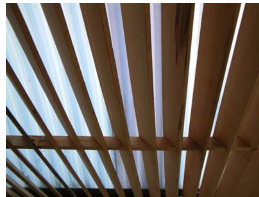
Ljuset silas genom det enkla innertaket bestående av träribbor. Flyttbara fiberplattor gjorde det möjligt att avskärma ljuset.
