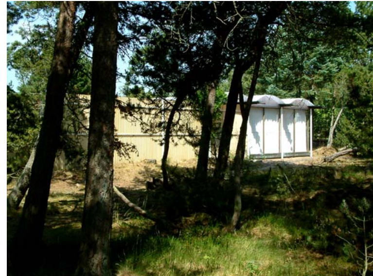
Huset ligger något inskjutet på fastigheten väl dolt av den uppvuxna grönskan. Det första man möts av är gul korrugerad plast.
