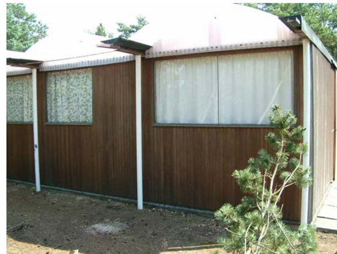
Norra fasaden. Galvaniserade järnstolpar utgör den bärande konstruktionen.
