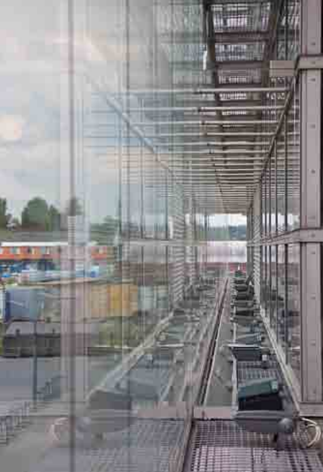
Sanomatalon lasijulkisivu lähikuvassa.
