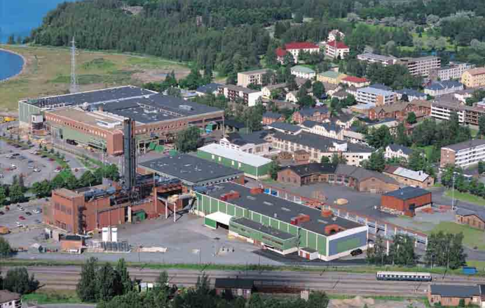
Ilmakuva Wärtsilän tehdasalueesta Vaasassa.
