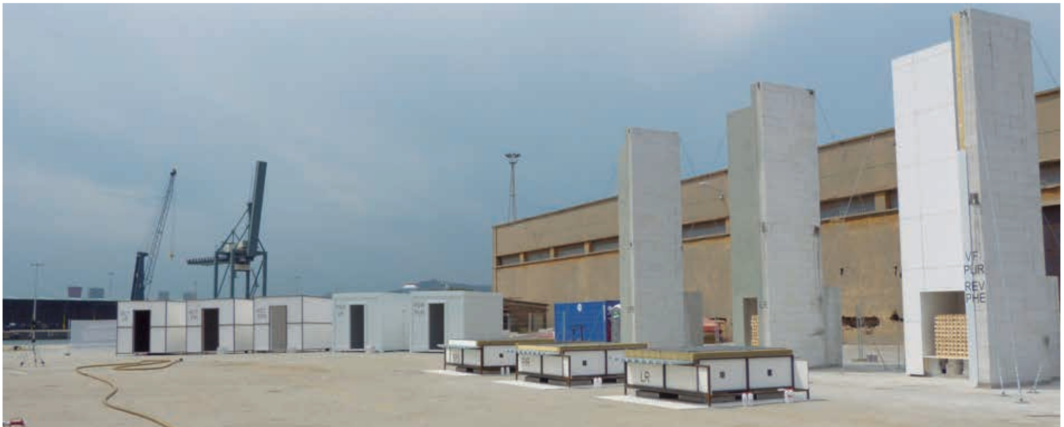
Vista del campo de ensayos
