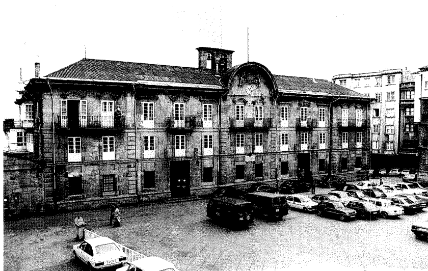
Figura 7. Fachada principal del Palacio del Gobernador-Capitán General y de la Real Audiencia.
