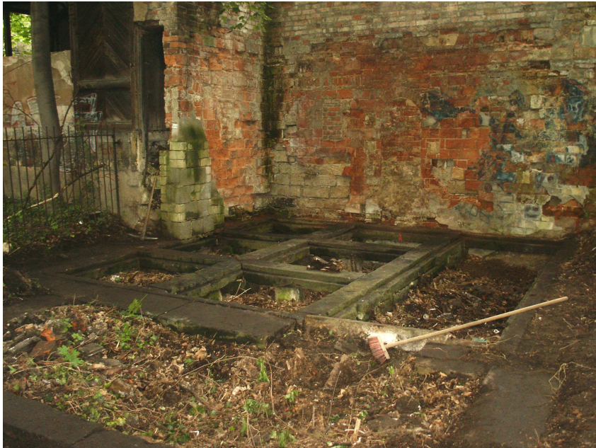
Abb. 5: Fundamente des hochplauenschen Wasserhauses 2006
