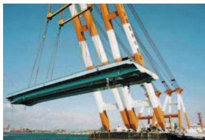
ポートアイランド連絡橋
