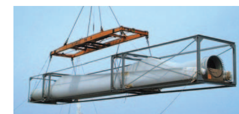
鋼構造物(風力発電プラント)の水切り作業 プラントの輸送(海陸一貫)から据付工事まで、豊富な経験と技術力を生かし、お客様のニーズにお応えします。 Unloading work of steel structure (wind power mills)
