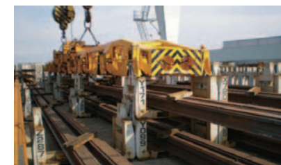
沿岸荷役作業 Uラック船には専用のUラックを使って船積作業。 Longshore cargo handling work
