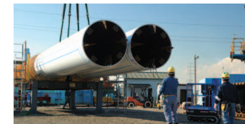
プラント用大径鋼管荷役作業
