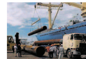
プラント輸送 ミンダナオ・コンテナバース建設設備 類の国際複合一貫輸送 Transporting plant and equipment for construction of Mindanao container berth
