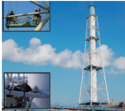
鉄塔支持型鋼製煙突補修
