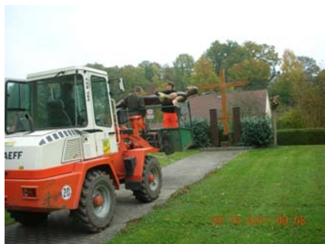
Der Bauhof unterstützte die Sanierung des Kreuzes auf dem Friedhof in Mainroth.
