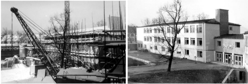
Bau der Schule am Bogenhauser Kirchplatz
