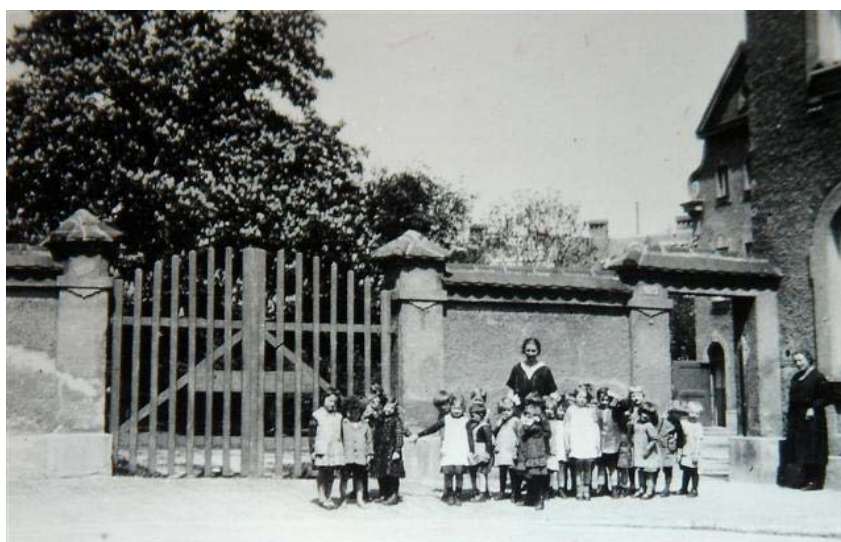
Das alte Schulgebäude am Bogenhauser Kirchplatz
