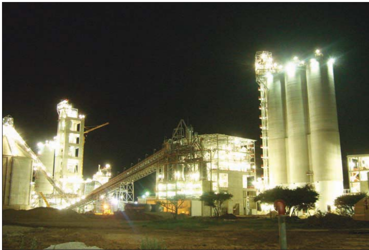
Das Ohorong-Zementwerk bei Nacht, leuchtet dank Nampower.
