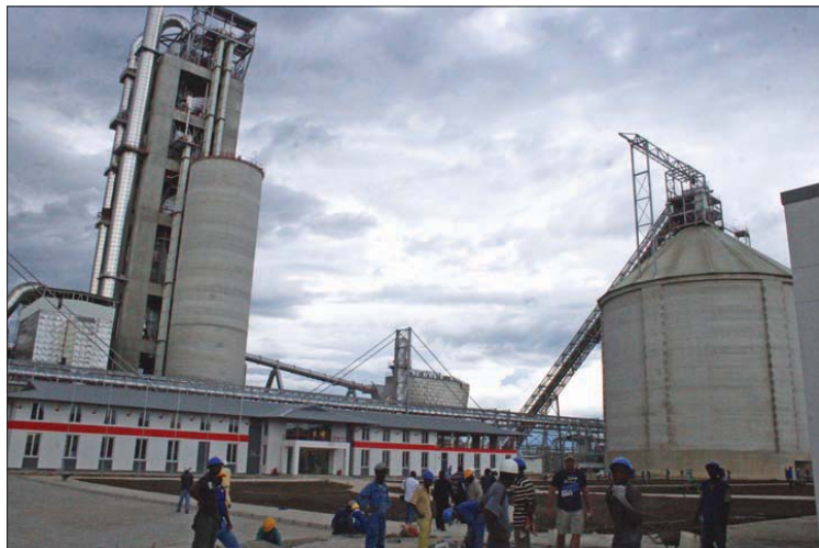
Auf dem 35 Hektar großen Fabrikgelände befindet sich u.a. der Vorwärmer-Turm (links), das Bürogebäude (im Vordergrund), in dem sich auch der Kontrollraum befindet, und der Klinker-Silo (rechts).
