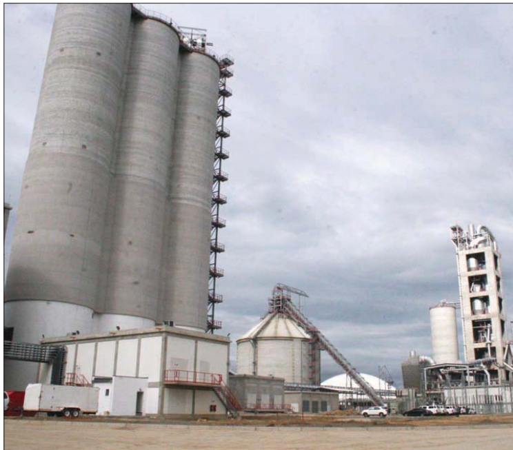
Auf der Ostseite des Fabrikgeländes befinden sich die drei Silos, in denen die verschiedenen Zementsorten gelagert werden.
