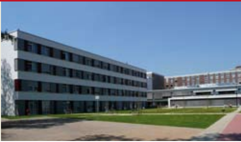
Neubau der stationären Orthopädischen Rehaklinik „rehaklinik am Berger See“ auf dem Gelände der BKB in Gelsenkirchen
