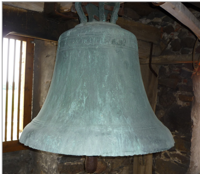
Abb. 1: Die große Glocke (13. Jh.). Durchmesser 1.15 m (≈ 42 uncia des karolingischen Fußes), Höhe ohne Krone 0.85 m. 42 = 6 \cdot 7 ist das Produkt zweier christlicher Symbolzahlen. Grundton fis.
