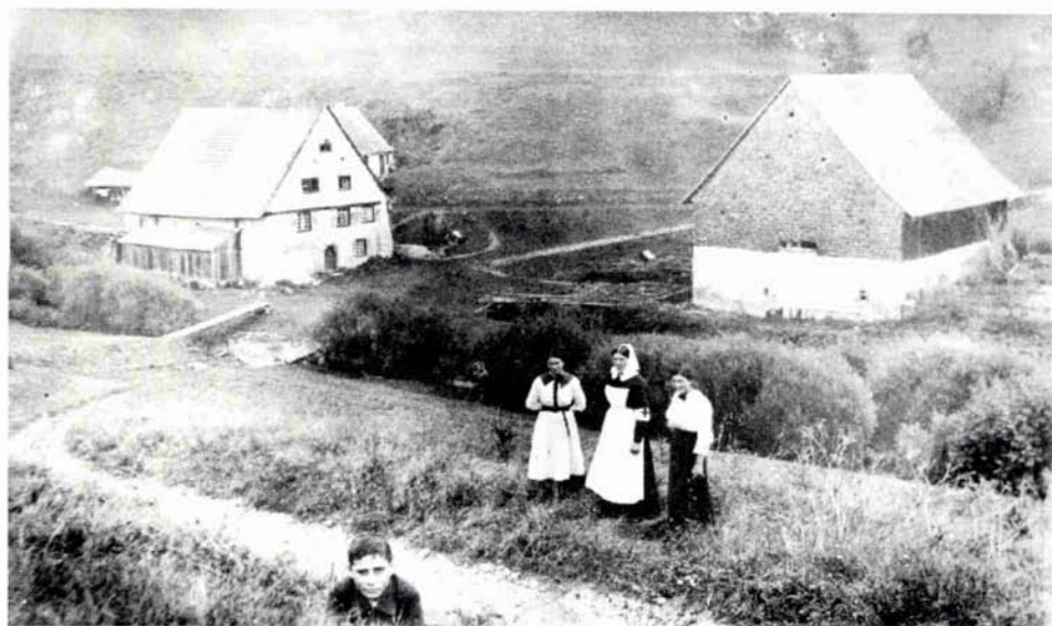
Abb. 1: Die Guggenmühle um 1914. Die drei Schwestern von Gustav Schreiter (Sohn) und der spätere Ehemann der jüngsten Schwester. Die Dächer sind z.T. mit Schindeln, z.T. mit Alpirsbacher Falzziegeln gedeckt, die heute noch auf dem Ökonomiegebäude liegen. Das Wasserrad ist umbaut, damit es im Winter nicht einfriert. Von dem Holzschopf hinter der Mühle sind noch Trockenmauerreste vorhanden. Der Fußgängersteg über die Gauchach ist hochwassersicher, wogegen die unterhalb liegende Behelfsbrücke bei jedem Hochwasser weggerissen wurde.
