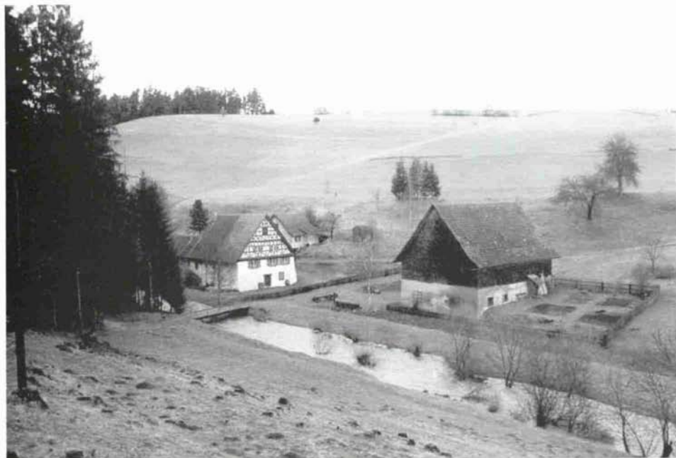
Abb. 3: Die Guggenmühle an der Gauchach bei Hochwasser im März 1997
