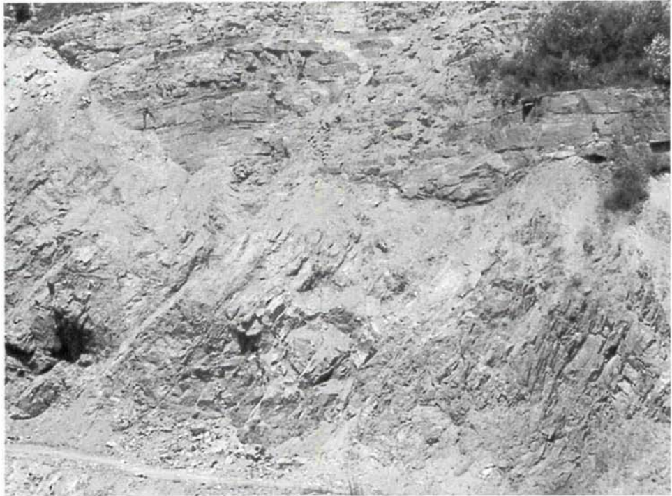
Abb. 6: Detail im nördlichen Abschnitt der Verwerfung (vgl. Abb. 2). Kleinstückiger Zerfall des Gneises nahe der Verwerfung und, weiter unten, dichte Zerklüftung. Oberhalb der Verwerfung die Schichten des Buntsandsteins. (Foto G. Reichelt)
