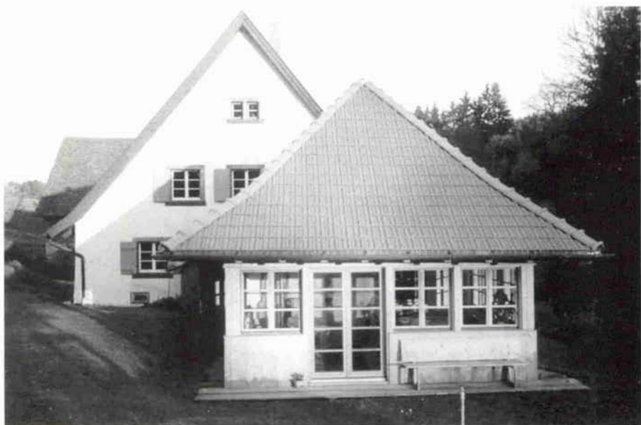
Abb. 8: Rückansicht der Guggenmühle 2001. Der Maschinenschuppen wurde umgebaut, um den rückwärtigen Giebel für Fenster frei zu bekommen. Dieselmotor und Haupttransmission sind unverändert erhalten geblieben. Vorn die Veranda in der Verlängerung des neuen Maschinenschuppens.
