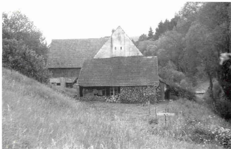
Abb. 7: Rückansicht der Guggenmühle 1974. Das abgeschleppte Dach des Maschinenschuppens verdeckt weitgehend den Giebel. Der kleine Anbau rechts ist das stille Örtchen. Im Vordergrund die Reste des Stellwehres im Mühlgraben.
