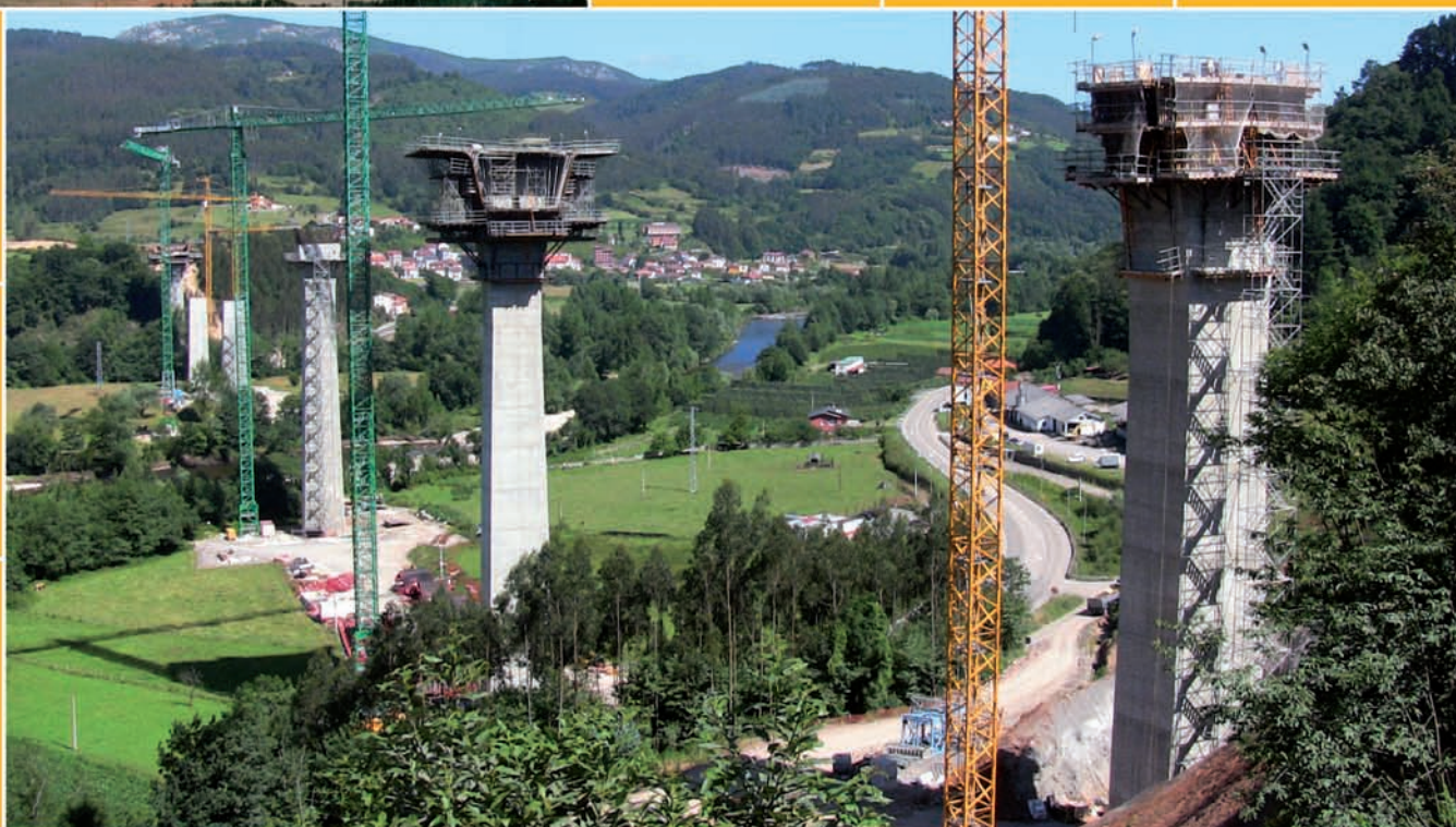
Viaducto sobre el río Narcea, Asturias
