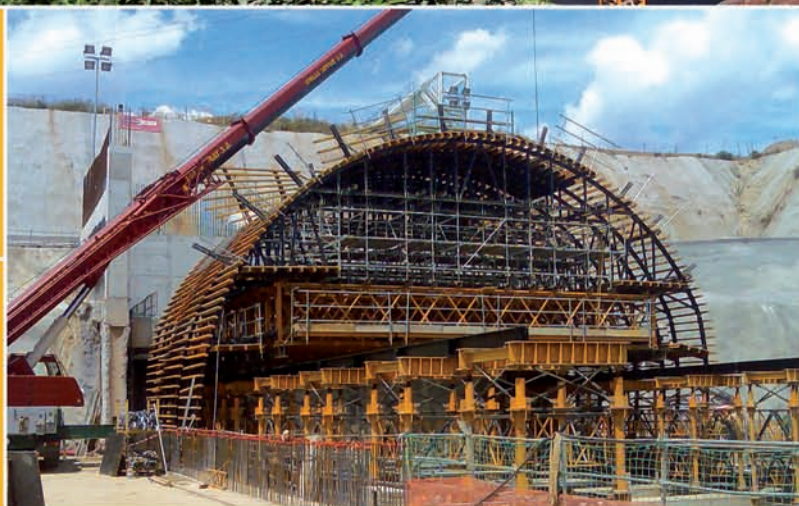
Autovía B-40, Tramo Viladecavalls-Terrasa
