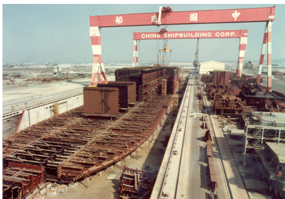
柏瑪奮進號油輪建造初期照片
