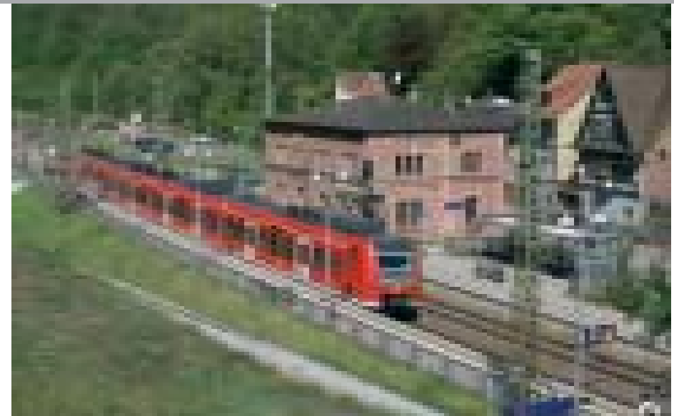
Der Haltepunkt Franckenstein wurde barrierefrei umgebaut, das frühere Empfangsgebäude wartet hingegen auf den Fortgang der Sanierungsarbeiten.
