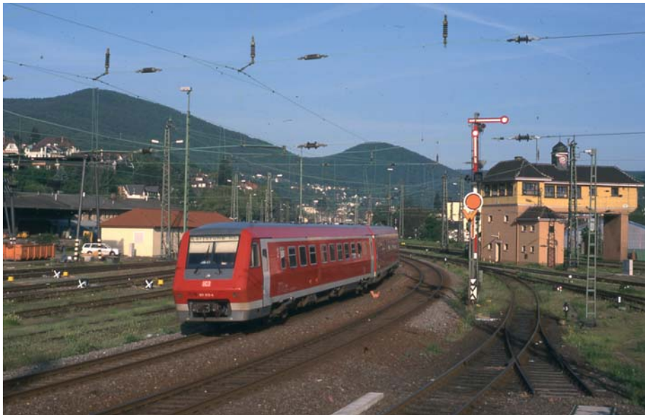
Beides ist Geschichte: Der 611 ist aus der Pfalz verschwunden und die Formsignale in Neustadt wurden in der Nacht vom 15. auf den 16. Mai 1999 durch modernste Elektronik ersetzt. Nur das markante Reiterstellwerk steht noch – funktionslos.
