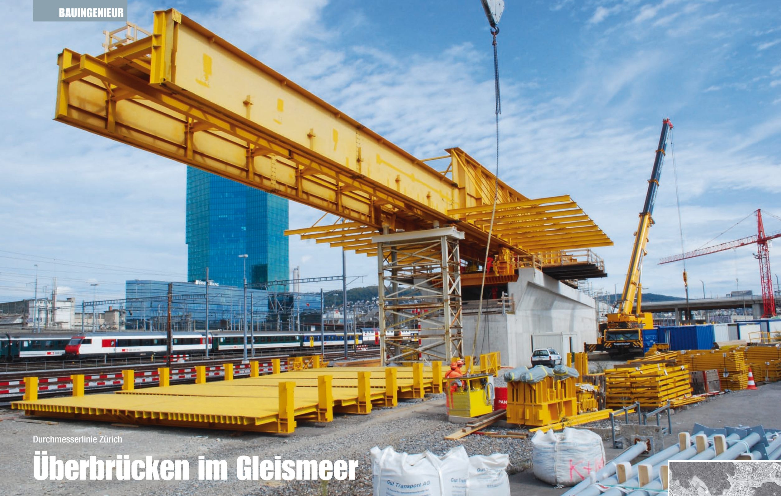
Mit einem 90 Meter langen Vorschubgerüst wird der Überbau für die Letzigrabenbrücke erstellt.
