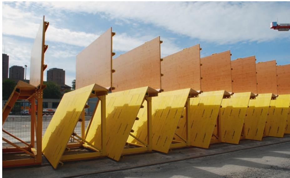
Die Schalungselemente für den Brückentrog der Letziggrabenbrücke stehen für die Montage an das Vorschubgerüst bereit.
