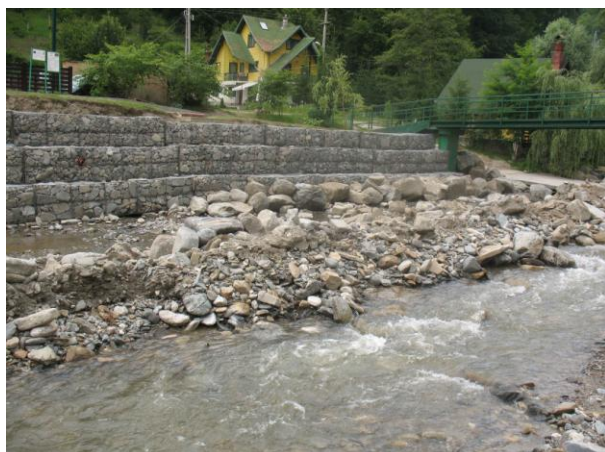
Figura 9 Râul Vâlsan - consolidări de maluri - ROSCI 0268 Valea Vâlsanului
