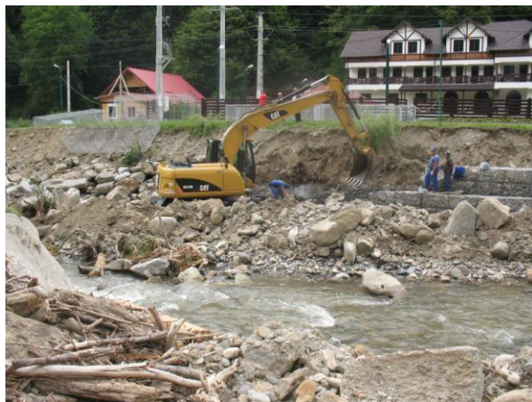
Figura 8 Râul Vâlsan - consolidări de maluri - ROSCI 0268 Valea Vâlsanului
