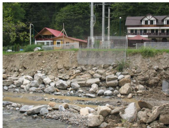
Figura 10 Râul Vâlsan - consolidări de maluri - ROSCI 0268 Valea Vâlsanului
