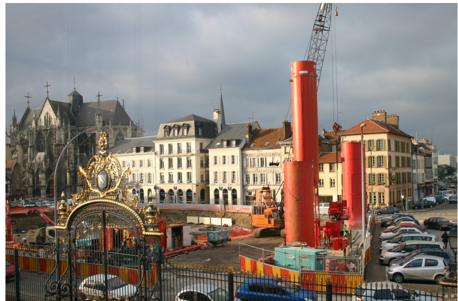
Travaux d'aménagement du parking souterrain, 2007-2008.
