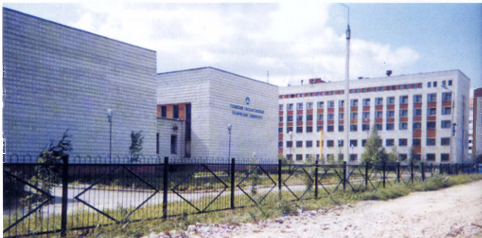
Здание Ухтинского ГТУ
