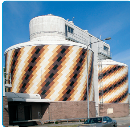
Sundsvalli reoveepuhastusjaama biogaasireaktorid.
