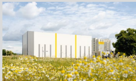
Mit 2.400 m² Grundfläche und 30 m Höhe eines der weltweit größten Hochregallager aus Holz.
